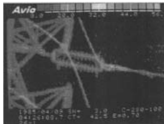
(b) 異常発熱を検知した状態
